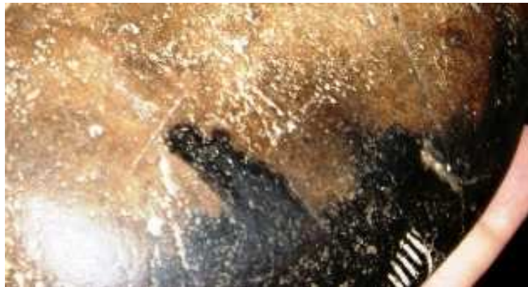
DETALLE DECOLORACIÓN EN PIEDRA DE ICA
